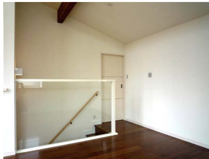
D棟ガラス階段手摺り
